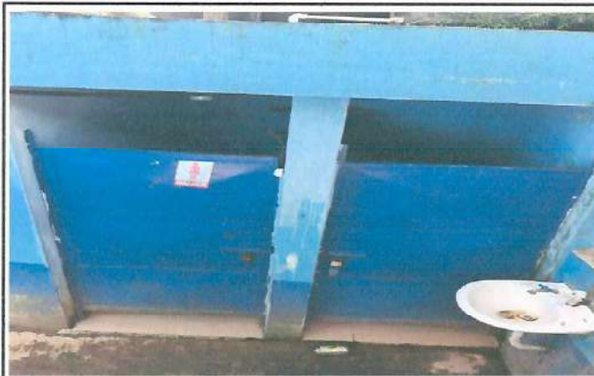
Foto 6: reparacion de los sanitarios.
