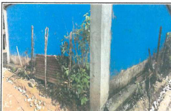
Foto 4: Reparación del muro perimetral.
