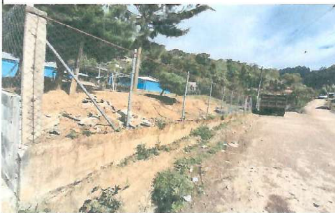
Foto 3: Reparacion del porton secundario.
