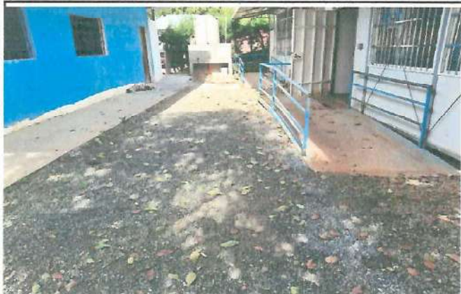
Foto 5: Losa de patio en el modulo 4
