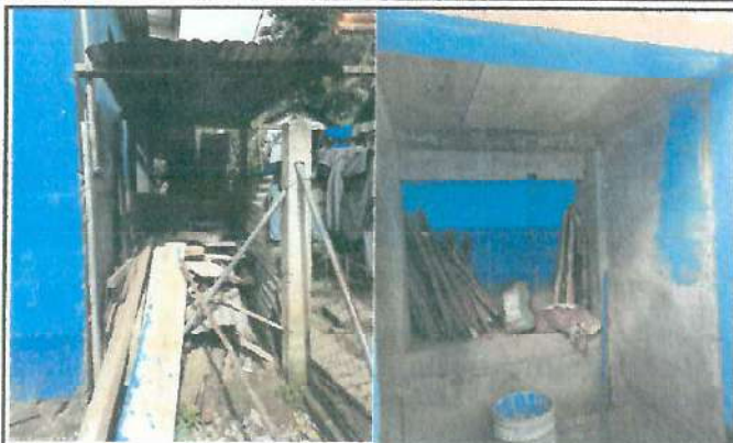
Foto1: Reparación de las bodegas de la Telesecundaria.
