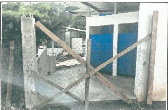
Foto 3: Reparación del porton secundario.
