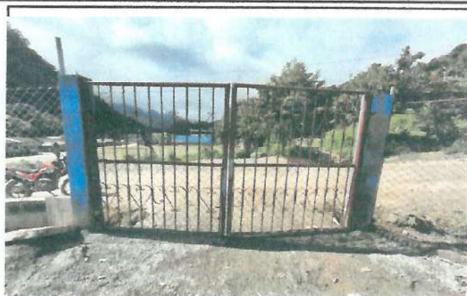
Foto 2: reparación del porton principal.
